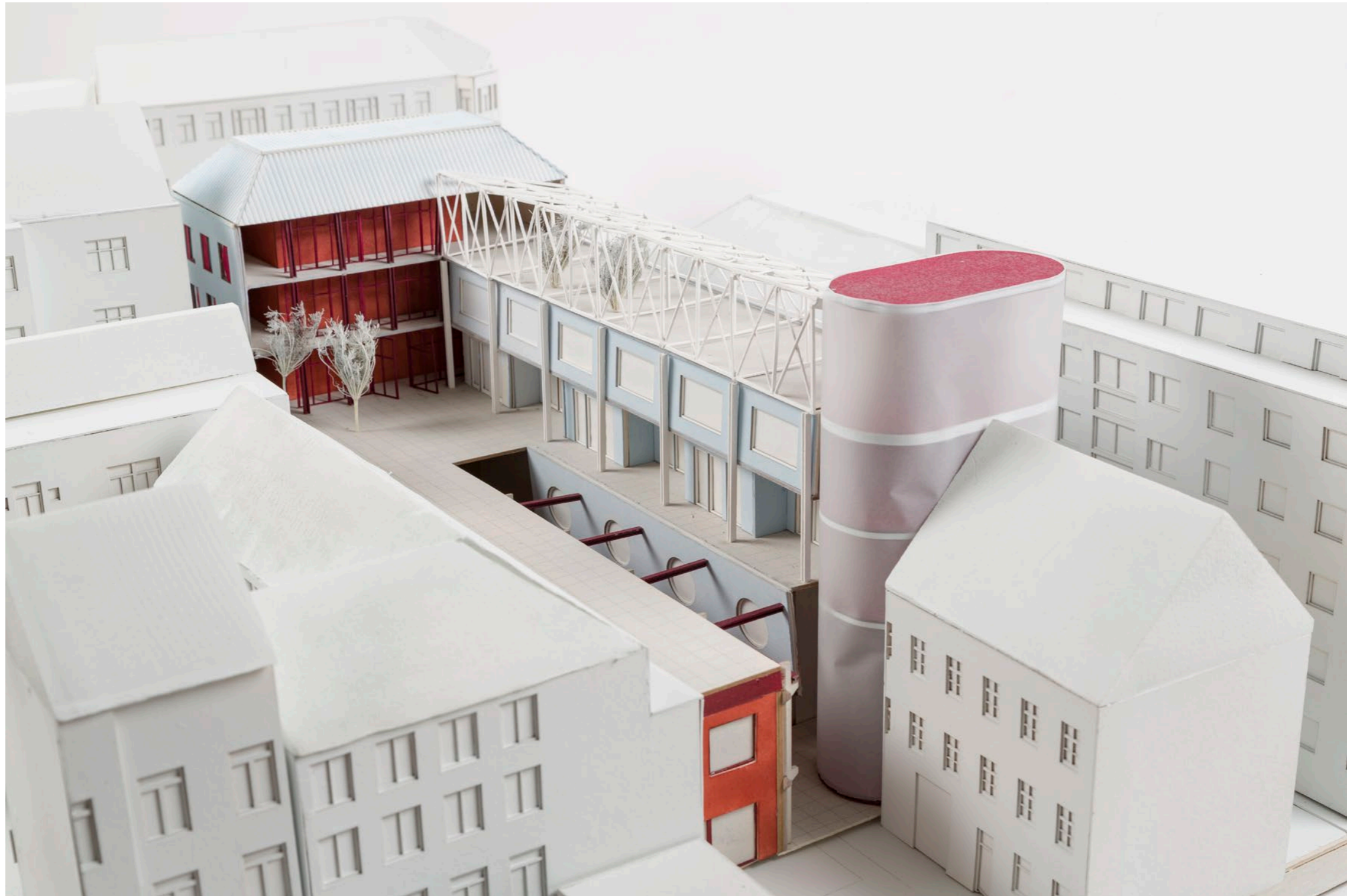
trägerüberdachung der passage
