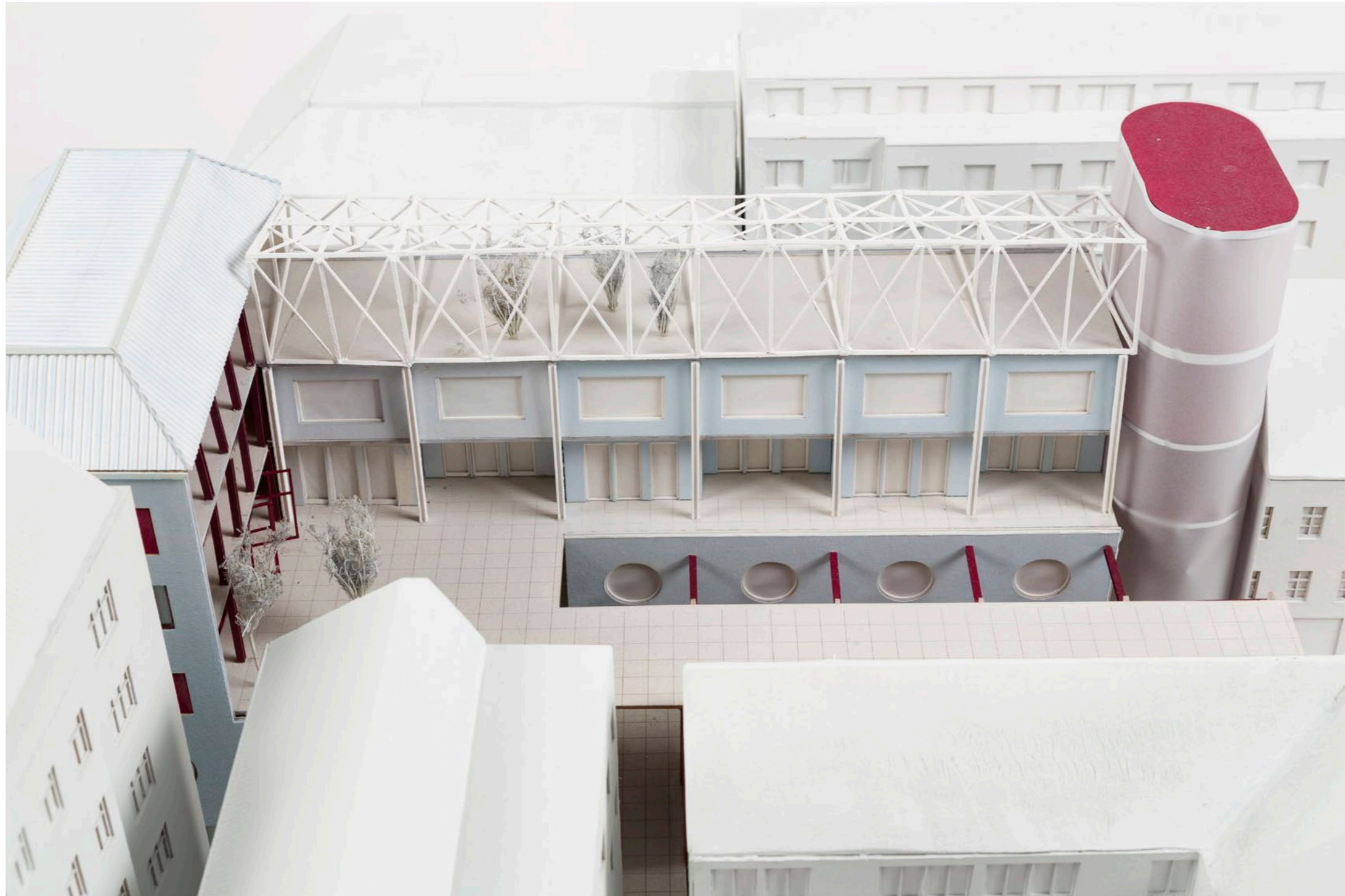
trägerüberdachung der passage
