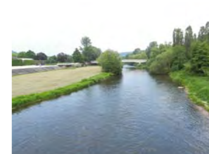
Das gleiche Ufer nach über 20 Jahren (2012)
