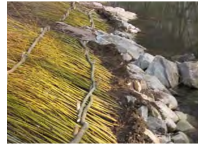
Detail der Spreitlage nach Fertigstellung
