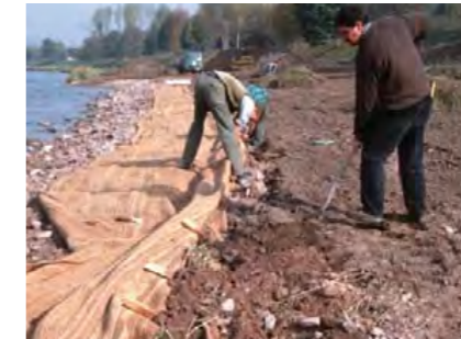
Bau 1990: eingelegte Soden, Verschließen des Gewebes
