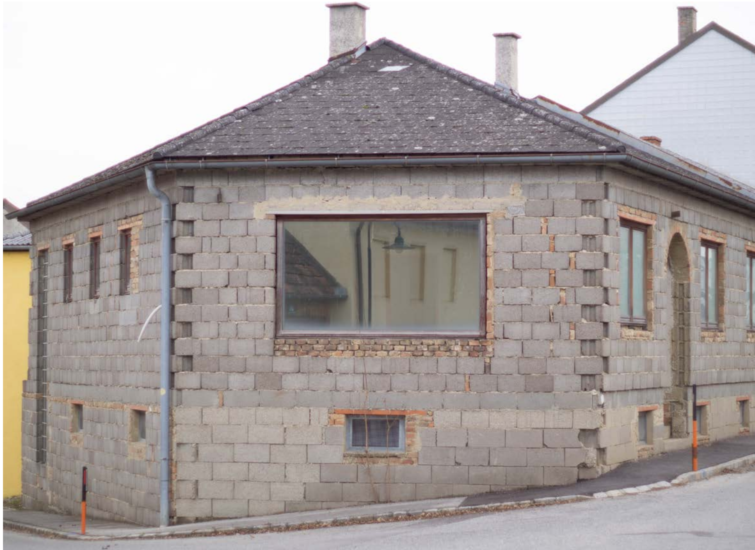
Gebäude im Rohbau seit 1970
