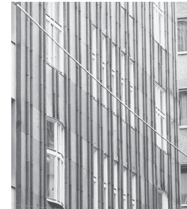
Aufnahme Zacherlhaus - Vertikalität und Öffnungen
