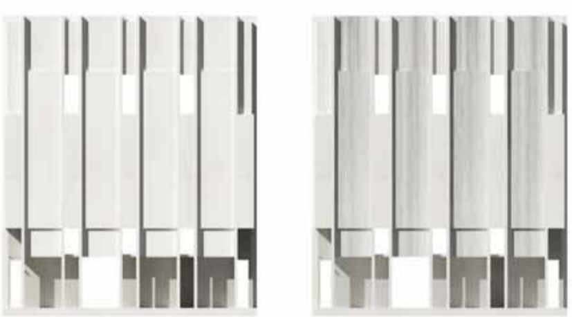
Fassade nach Herstellung Fassade bewittert
